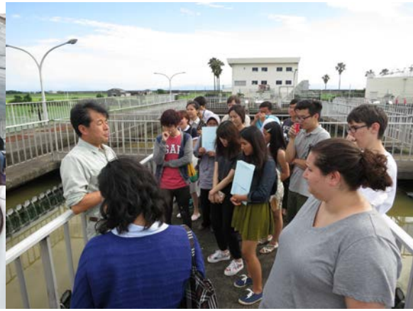
佐賀市下水浄化センター
